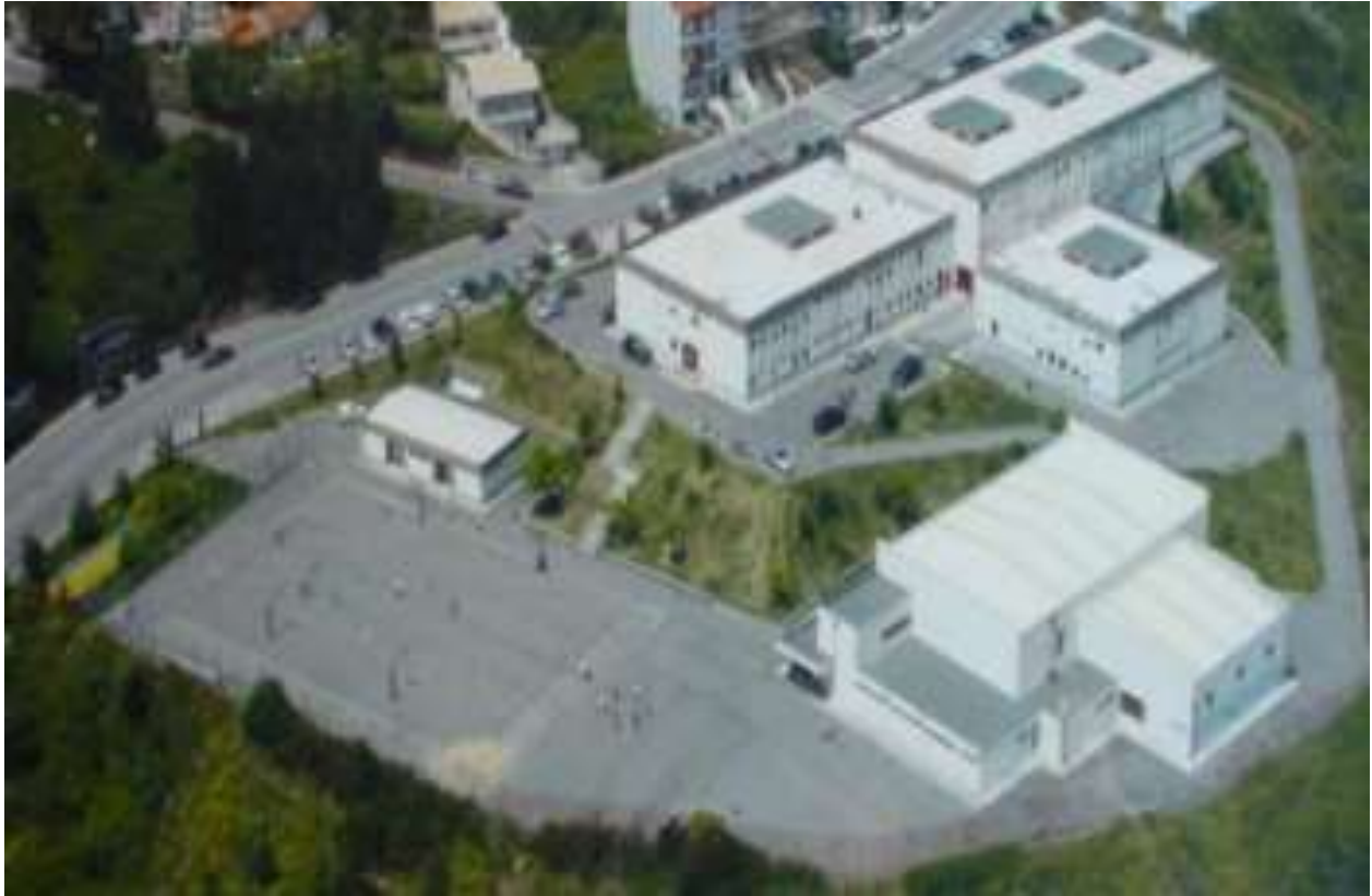
Figura 1 – Vista aérea da Escola Secundária de São Pedro da Cova
