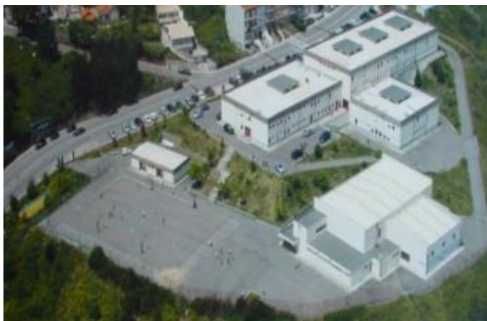
Figura 1 – Vista aérea da Escola Secundária de São Pedro da Cova
